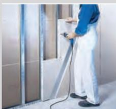
En caso de doble placa fijar ésta alternando las juntas. La distancia entre ejes de tornillos de fijación de la primera placa será de 75 cm, cada 25 cm en la segunda. No colocar una junta entre placas a la altura de los cercos (puertas y ventanas).
