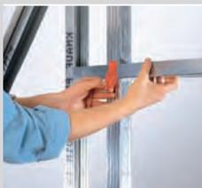
Colocar las fijaciones entre los perfiles verticales a la altura necesaria. Dejar 100 cm de separación para las fijaciones horizontales; 50 cm para las fijaciones verticales.
