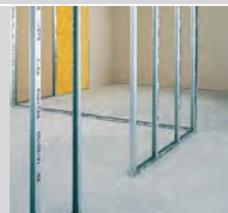
Colocar los perfiles verticales, previamente cortados. Separación entre los perfiles verticales: 60 cm.
