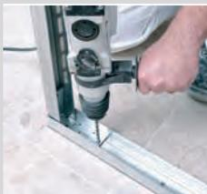
Marcar sobre suelo, techo y tabiques perimetrales la posición de los perfiles. Aplicar el Mastic de Knauf o la banda de estanqueidad sobre el dorso de los perfiles periféricos y fijarlos.
